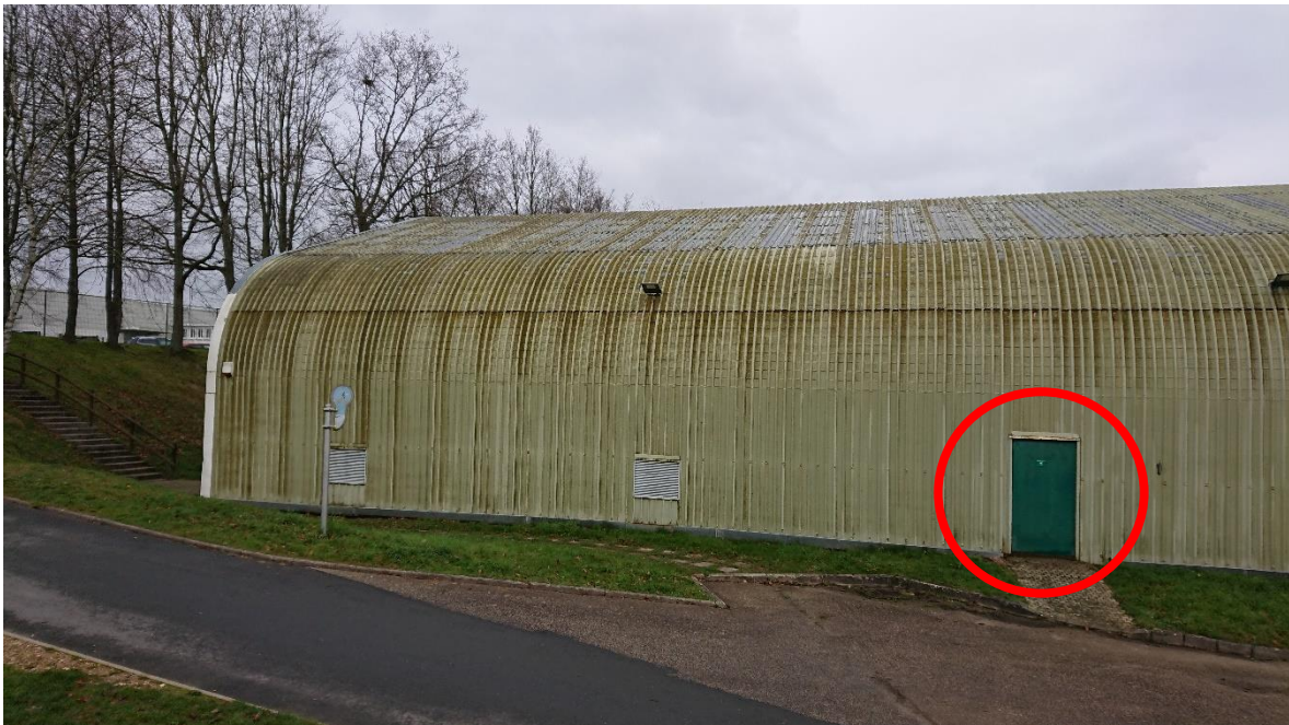
Figure 1 - Façade Sud-Ouest- Porte à déposer
