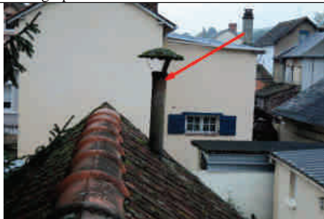
ATELIER 2 CONDUIT + CHAPEAU EN FIBROCIMENT
