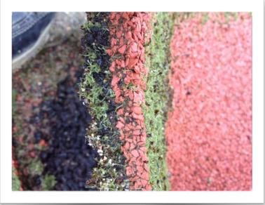
La planimétrie du revêtement est conforme (défauts <3mm sous la règle de 4m). Une contre pente a été repérée au niveau des sautoirs en longueur.
