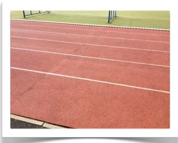
Les joints froids ont été découpés avant réalisation du raccord entre les passes ce qui provoque aujourd'hui les phénomènes de retrait constatés. Quelques reprises ont été effectuées. Il faut noter que ce travail a été bien fait (raccords «propres»).
