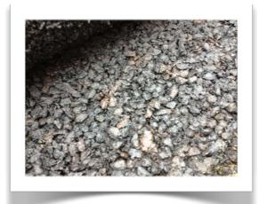
L'enrobé porteur semble de bonne facture. Des carottages et analyses (teneur en bitumes, granulométrie) pourront être réalisés en phase AVP pour confirmer ce constat.
